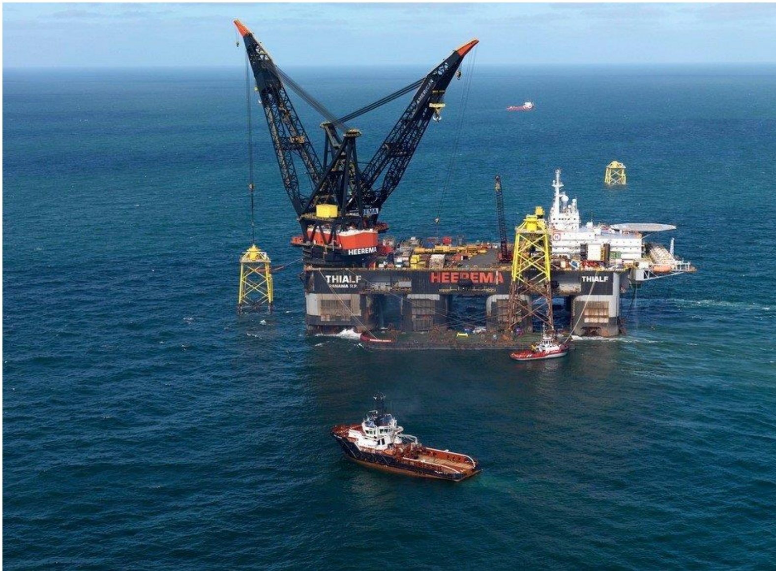
Norske leverandører leverte store deler av Tysklands først havvindpark i 2019. Foto: NorWind AS. Faksimile fra TU.no
